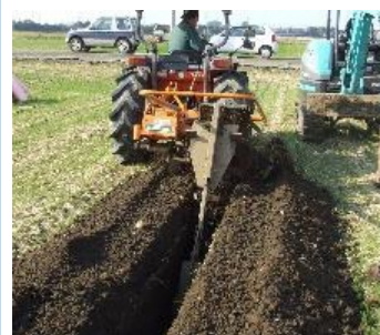
暗渠排水の整備
