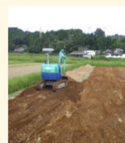
土層改良（客土）
