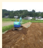
土層改良（客土）
